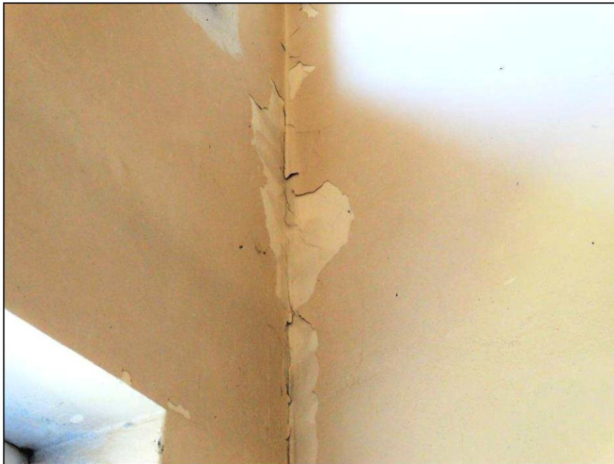
Nejedlého 6 – Trhlina v koutě u okna na schodišti – 13.4.2022 – Beze změny
