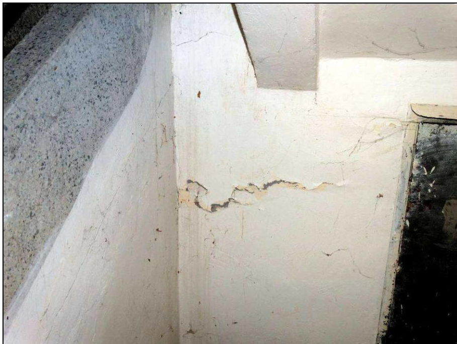
Nejedlého 2 – Trhliny pod schodištěm v 1.PP – 12.4.2022 – Beze změny
