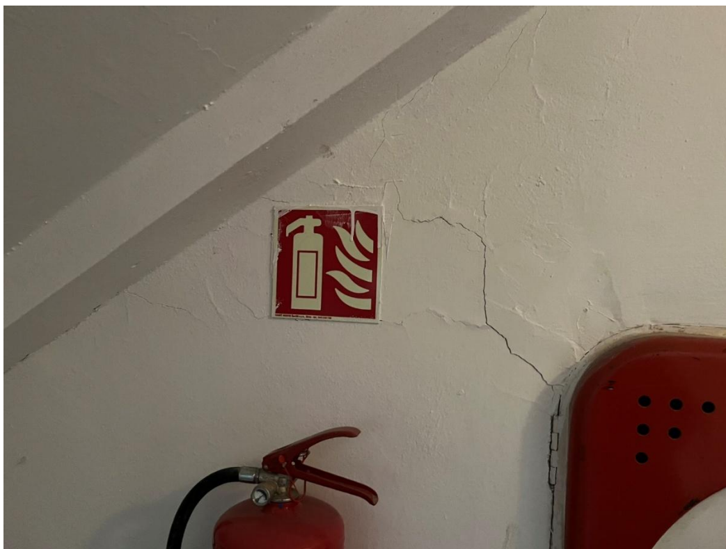
Nejedlého 2 – Trhlina u hydrantu v 1.PP – 12.4.2022 – Beze změny
