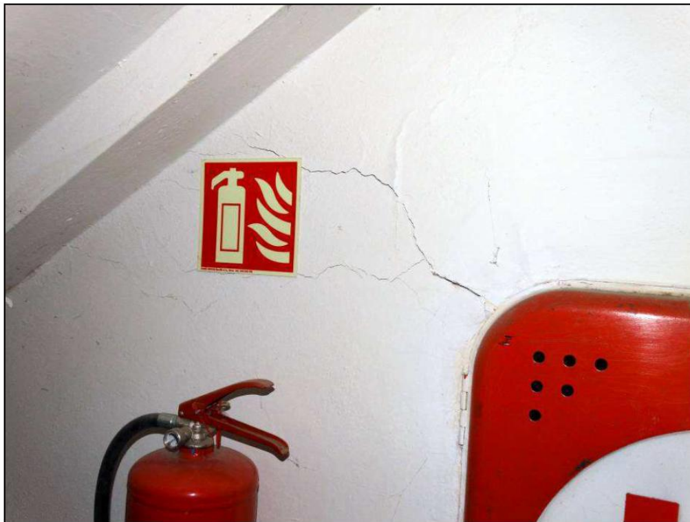
Nejedlého 2 – Trhlina u hydrantu v 1.PP – 12.4.2022 – Beze změny
