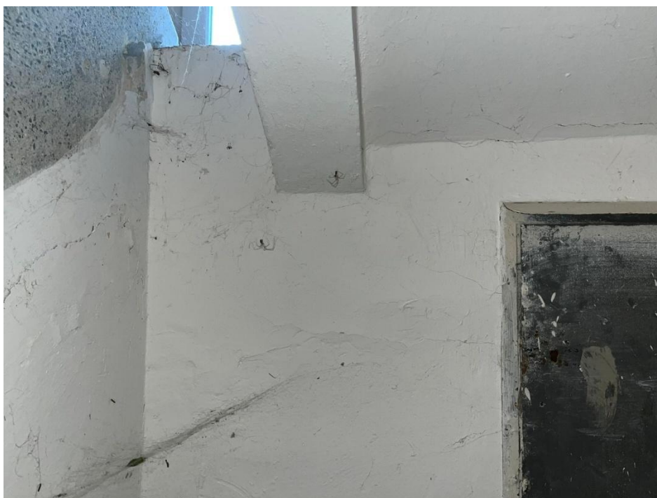
Nejedlého 2 – Trhliny pod schodištěm v 1.PP – 12.4.2022 – Beze změny
